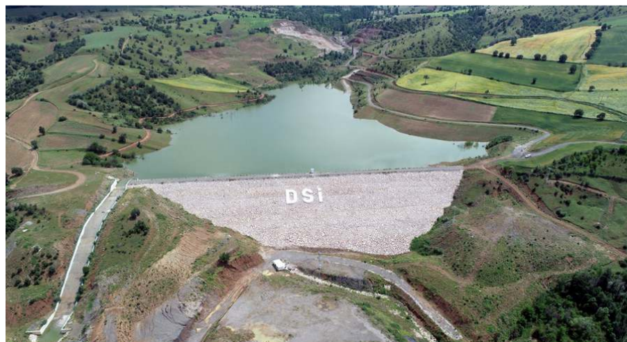
Baraj sayesinde 4 bin 10 dekar tarım arazisi suya kavuşmuş oldu.
