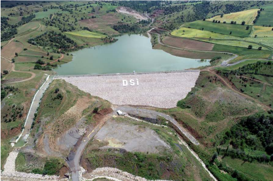
Baraj sayesinde 4 bin 10 dekar tarım arazisi suya kavuşmuş oldu.
