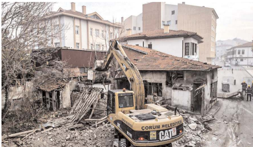
Alaybey ve Emiraahmet Sokak'taki metruk binalar yıkıldı.
