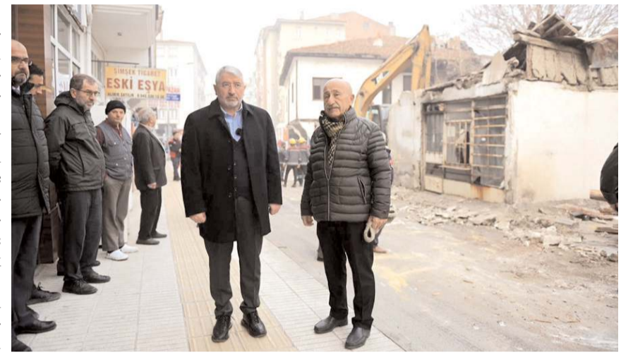
Başkan Aşgın, yıkım çalışmalarını yakından takip etti.
