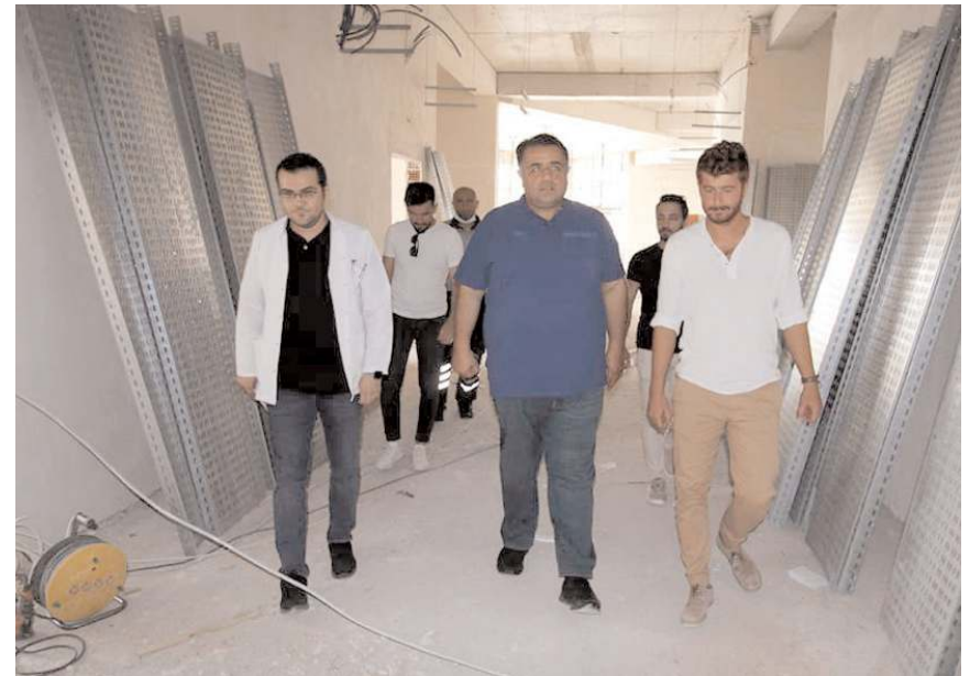
Milletvekili Av. Oğuzhan Kaya, inşaat çalışmalarını inceledi.
