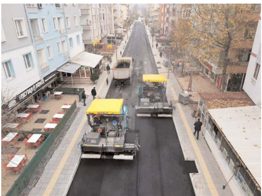
Belediye Millet ve Vatan Caddelerinde asfalt yenileme çalışması yapıyor.
