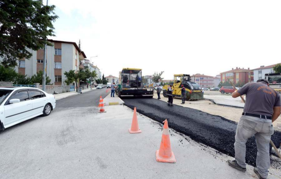
Yolda 1.900 ton stabilize 9 bin 800 ton mekanik serimi ile kazı ve dolgu çalışması yapıldı.
