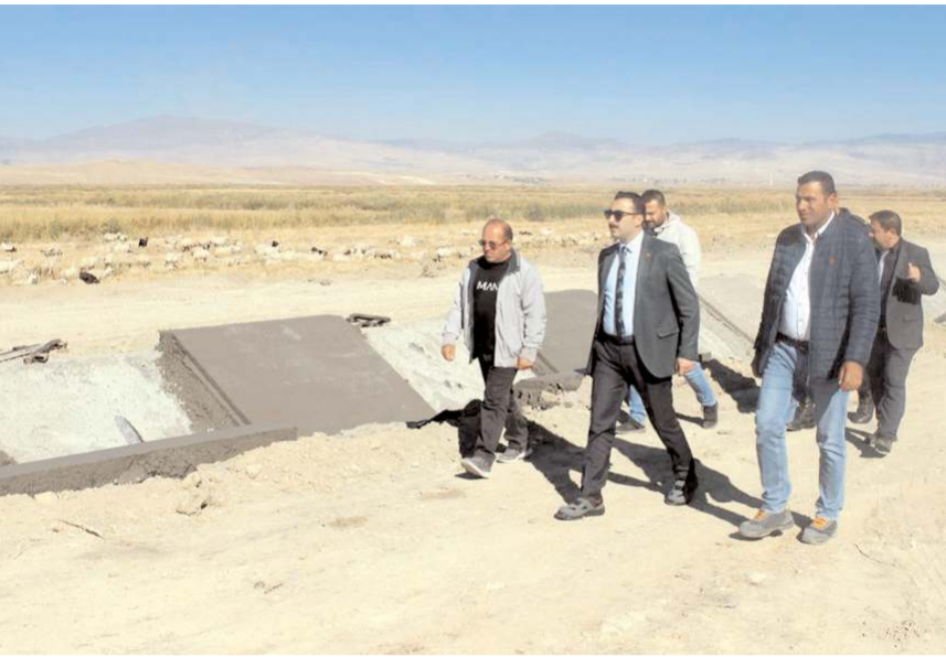
Kaymakam Şahin, Kızılırmak Tımarlı 2. Kısım Sulama Projesi inşaatında inceleme yaptı.
