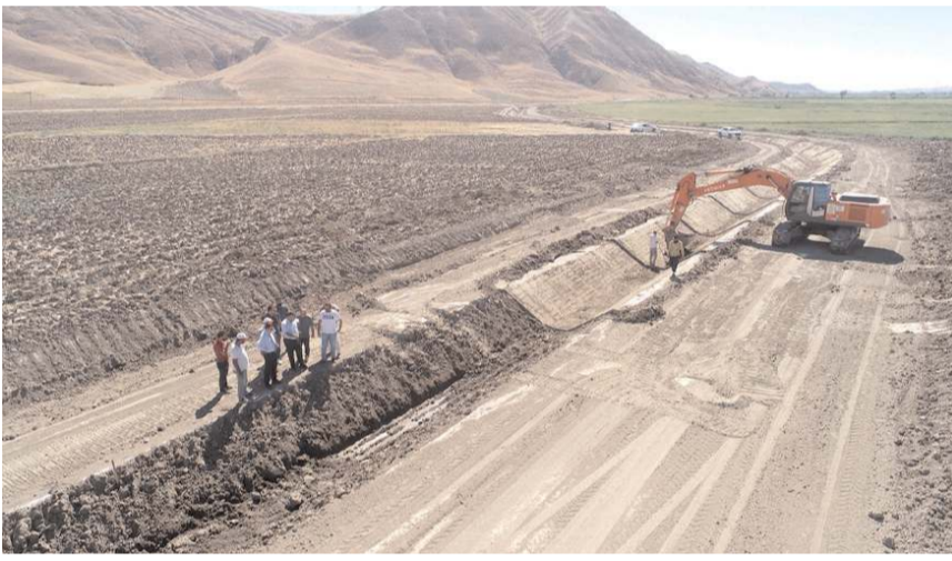
Projenin kalan kısmının tamamlanması için çalışmalar hızla devam ediyor.
