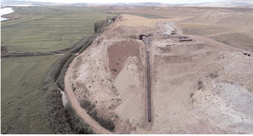
Projenin Çorum bölümünde 49 bin 400 dekarlık alanda çalışmalar tamamlandı.
