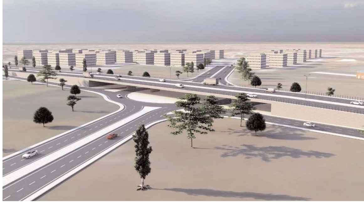
Çevre Yolu ile Akşemseddin Caddesi birleşimine yapılan farklı seviyeli kavşak projesinde çalışmalar hızla devam ediyor.
