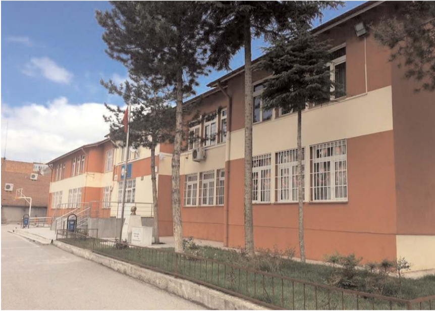
Zafer İlkokulu'nun eski binası yıkıldı.
