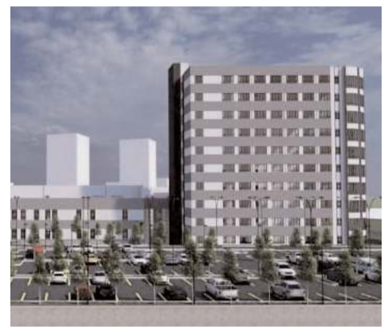
İhale kapsamında eski devlet hastanesinin mevcut binası güçlendirilecek ve etrafına ek binalar yapılacak.
