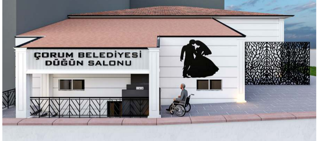
Düğün Salonu Mimar Sinan Mahallesi'nde Cuma Pazarı'na karşı inşa ediliyor.
