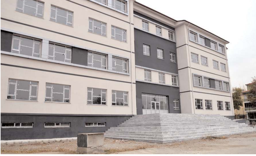
Eti Anadolu Lisesi'nin yeni binasının inşaatı devam ediyor.
