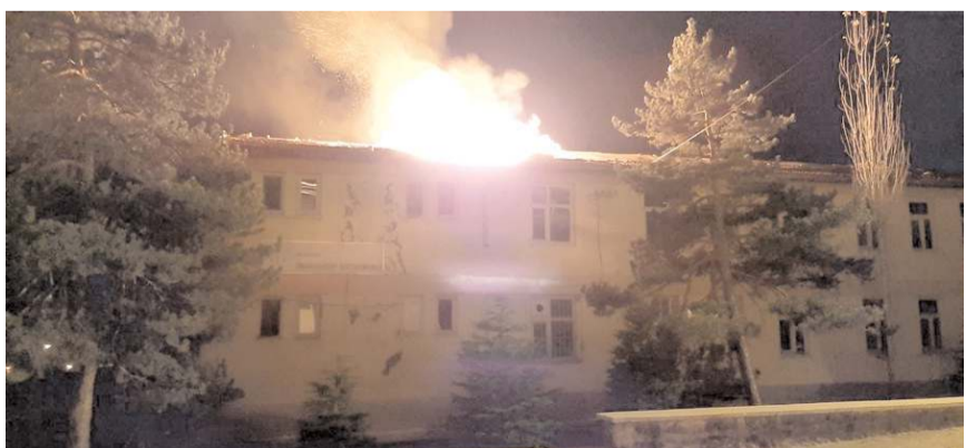
Yıkım aşamasında olan Dodurga İmam Hatip Ortaokulu'nun çatısında yangın çıktı.
