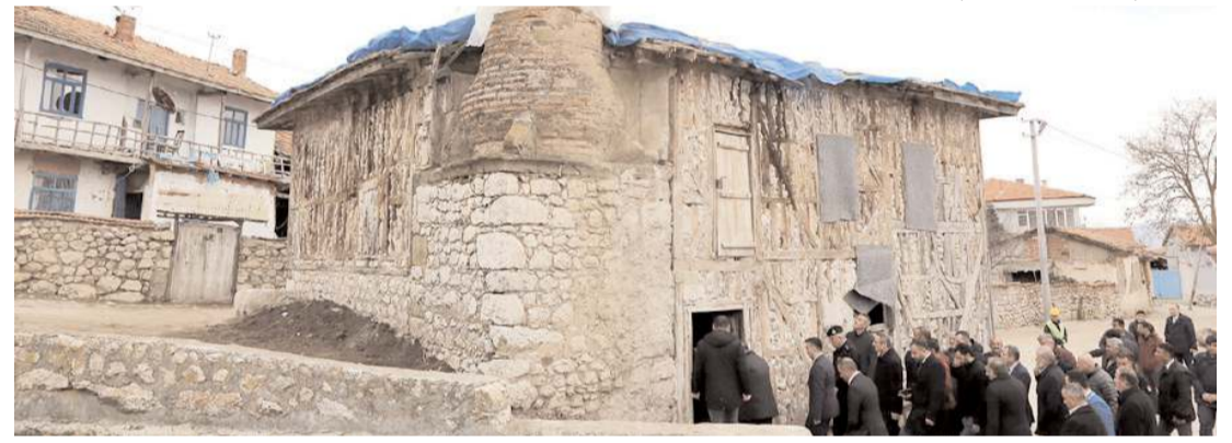
Cami bakımsız olduğu için ibadete kapalı durumda.
