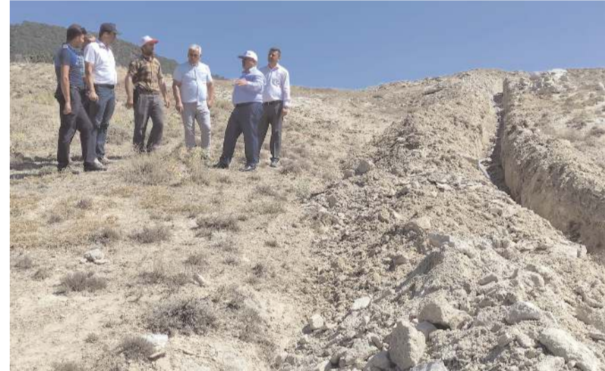
Başkan Ünlü, içmesuyu hattı döşeme çalışmalarını yerinde inceledi.
