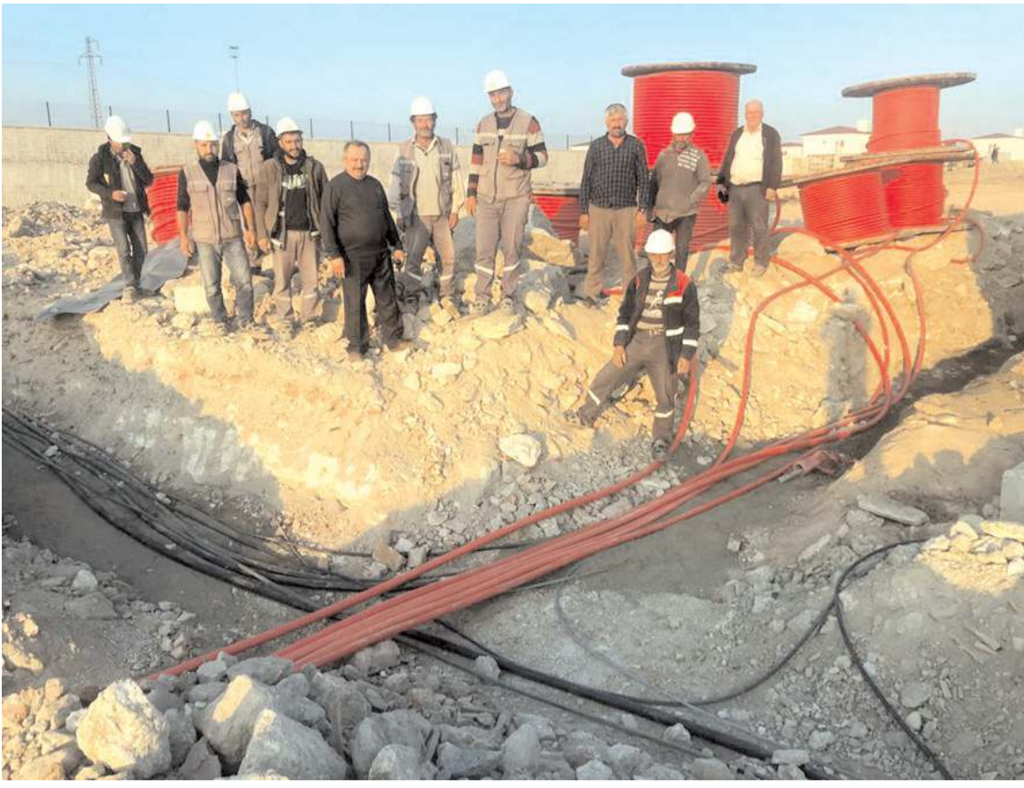
Zanaatkarlar Küçük Sanayi Sitesi Yapı Kooperatifi'nde elektrik hatları yer altına döşeniyor.
