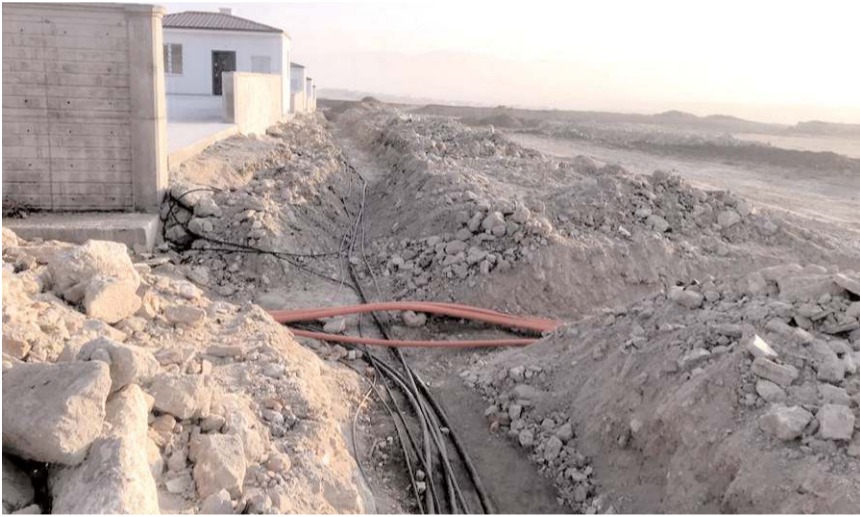
Yapımı tamamlanan Hurdacılar Bölümünde elektrik hatlarının yer altına alınmasına başlandı.
