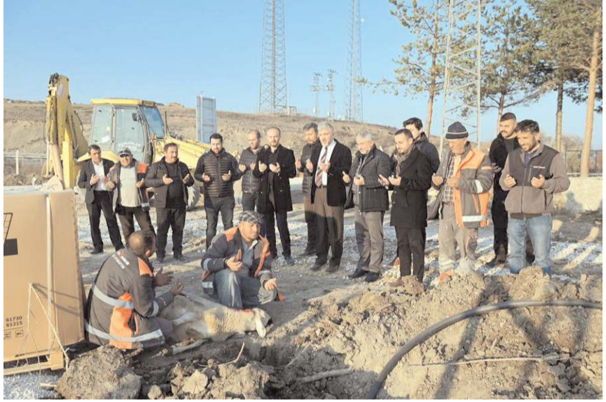
Eskice Köy'deki Güneş Enerji Santrali'nin kurulum çalışmaları başladı.
