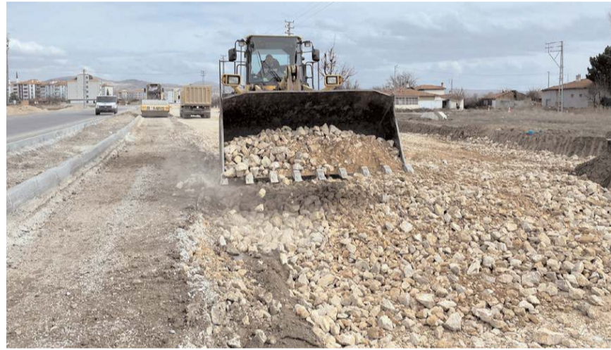
Yeni yapılan yol ile Çiftlik Pınarı Caddesi, Çevre Yoluna bağlanacak.
