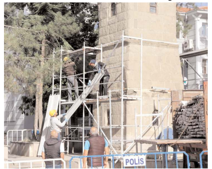
Restorasyon çalışmaları kapsamında iskele kurulumu yapılıyor.
