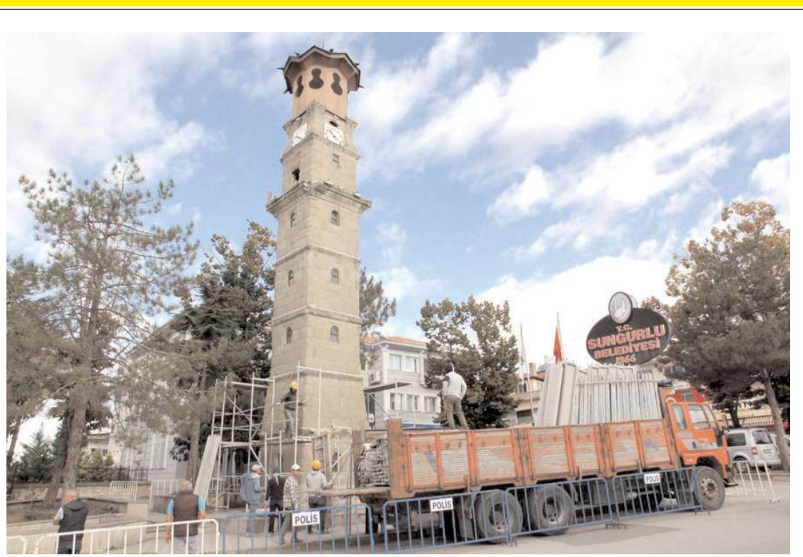
Sungurlu Saat Kulesi'nin restorasyon çalışmaları başladı.
