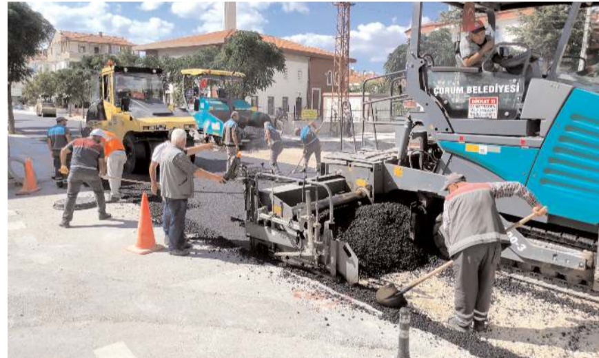
Çorum Belediyesi, Gülabibey Mahallesi’nde asfalt çalışması yapıyor.
