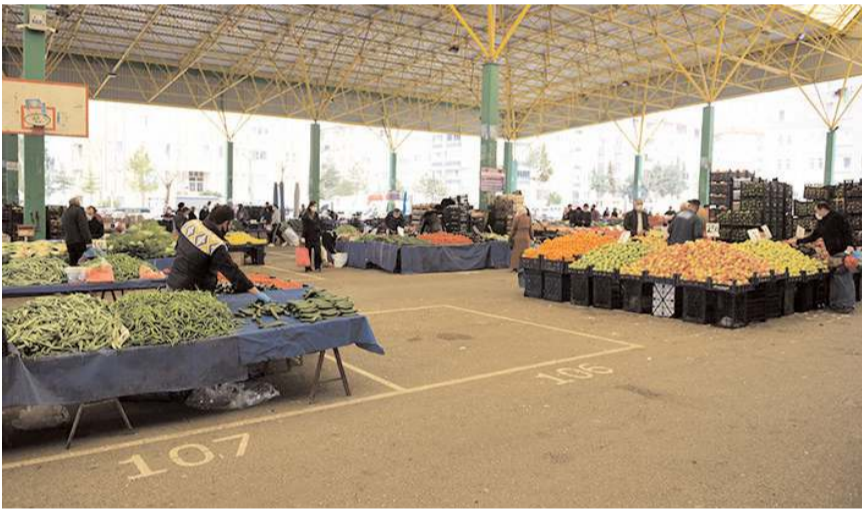
İhale kapsamında pazar yerlerinde bakım ve onarım çalışması da yapılacak.
