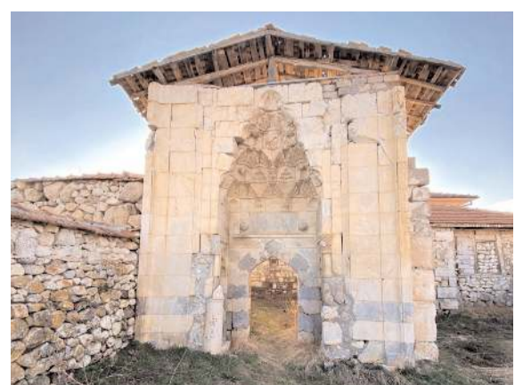
Hüseyin Gazi Türbesi'nin restorasyon ihalesi Kasım ayında yapıldı.
