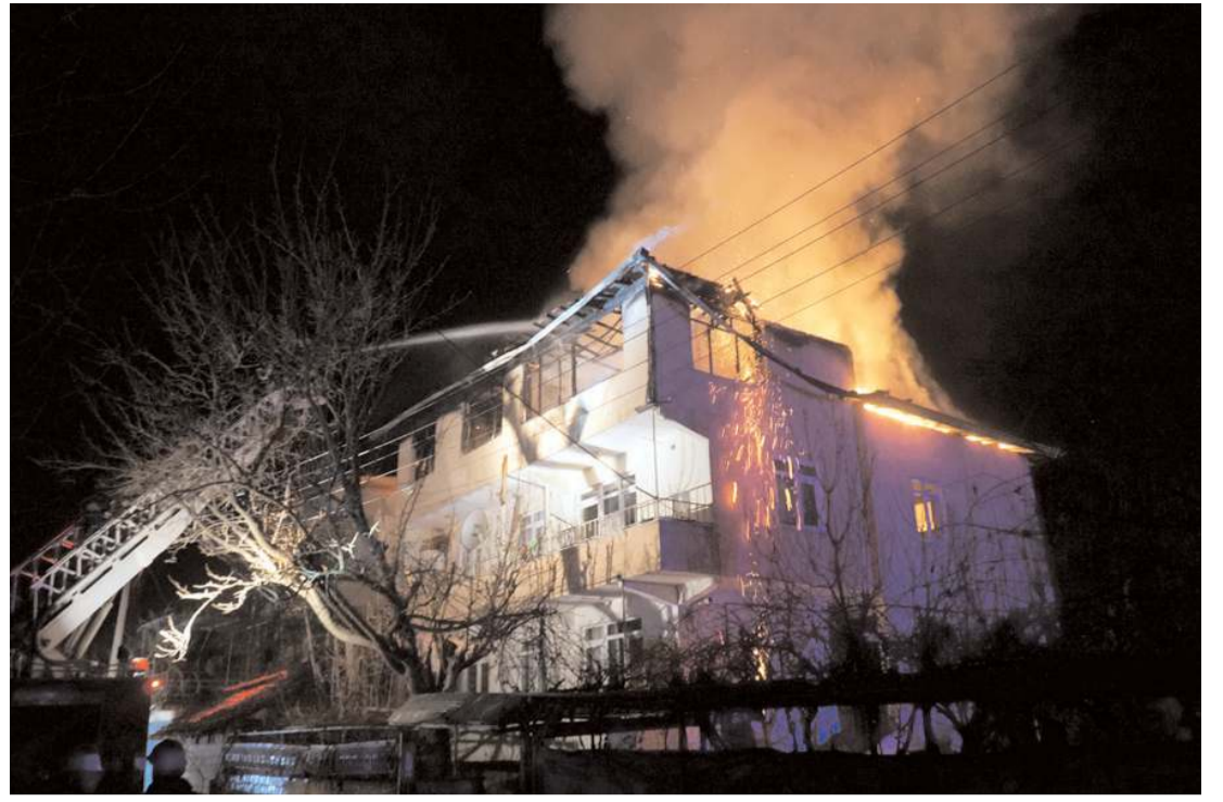
Olay Çay Mahallesi'nde Selamet Kavlak'a ait 2 katlı evde meydana geldi.
