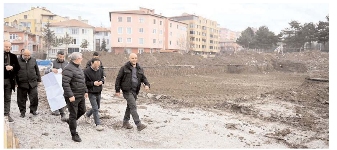
Belediye Başkanı Halil İbrahim Aşgın, inşaat çalışmalarını yerinde inceledi.
