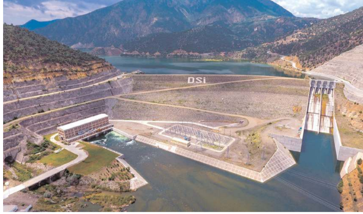
Obruk Barajı ve Hidroelektrik Santrali
