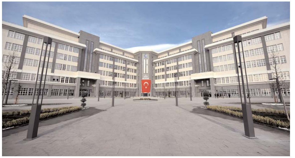
Çorum Belediyesi yeni hizmet binası geçtiğimiz günlerde faaliyete geçmişti.
