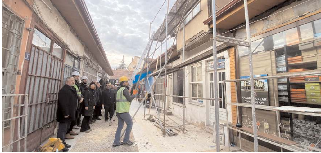
Arastada çatıları yenilenen dükkanlarda cephe sağlıklaştırma çalışmaları başladı.
