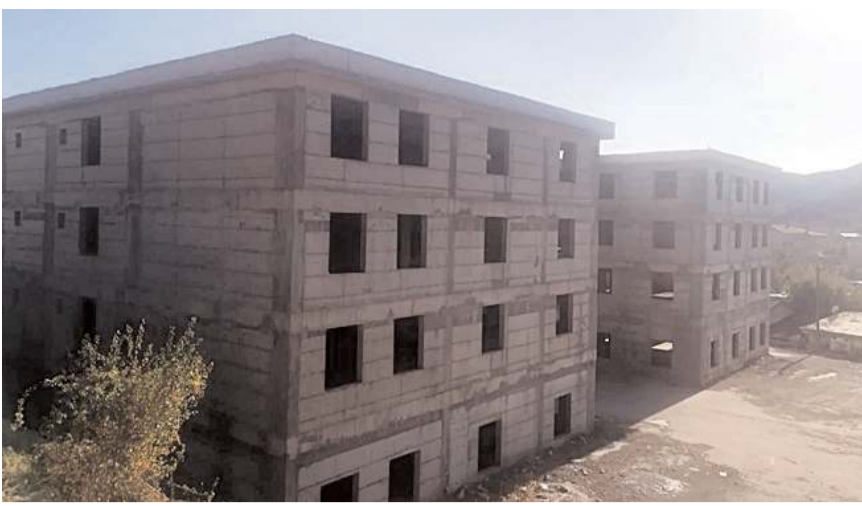
İskilip Meslek Yüksek Okulu binası inşaatı.
