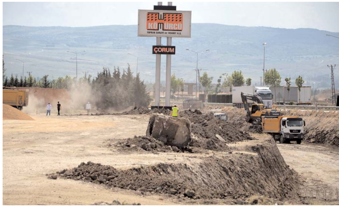
Kavşak projesi 4,2 km uzunluğunda bağlantı yolları, toprak tesviye, sanat yapıları, köprü ve üstyapı işlerini kapsıyor.
