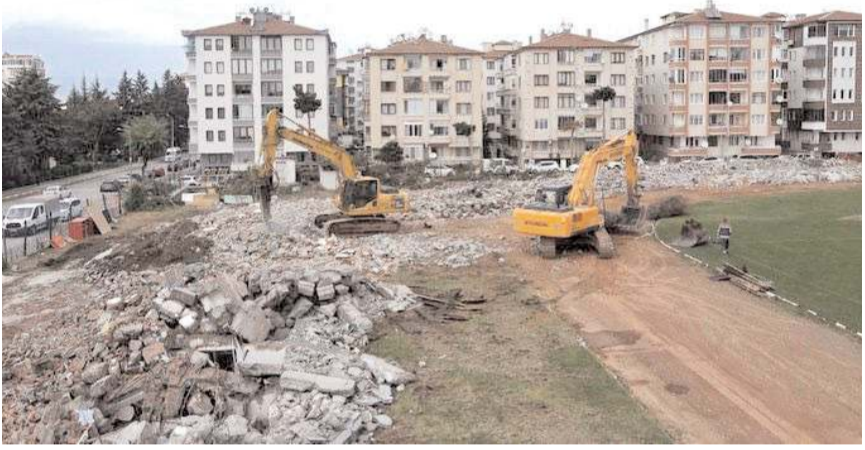
Stadin yıkımı tamamlandı.
