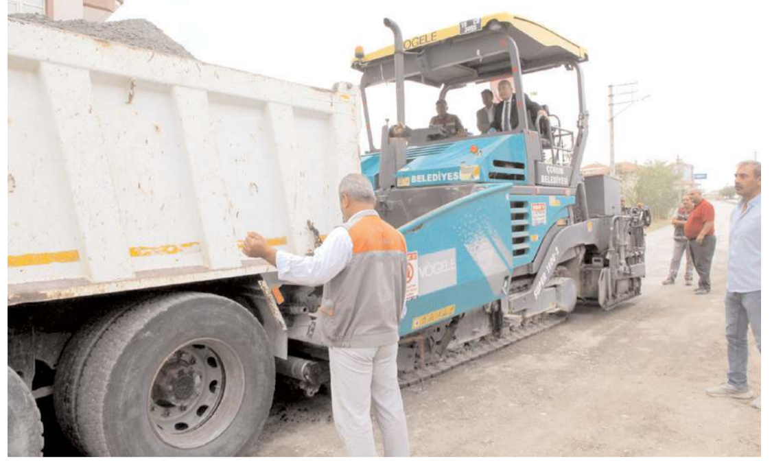
Sungurlu'da önceden belirlenen yollara beton serilmeye başlandı.
