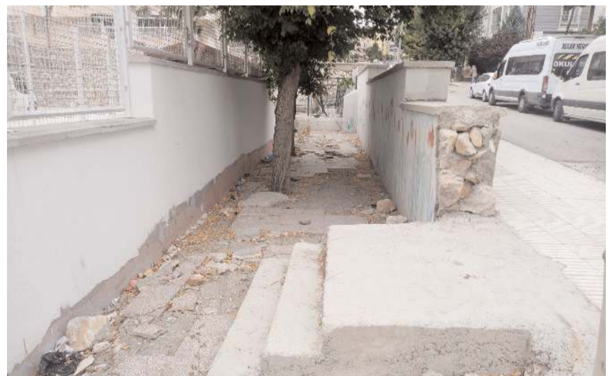
Yeni okul binası ile birlikte yeni duvarda yapılan eski duvar kullanılmaz hale hale geldi.
