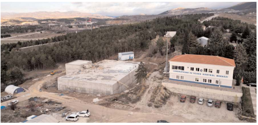
Su deposu Bahabey İçme Suyu Arıtma Tesisi içine yapılıyor.
