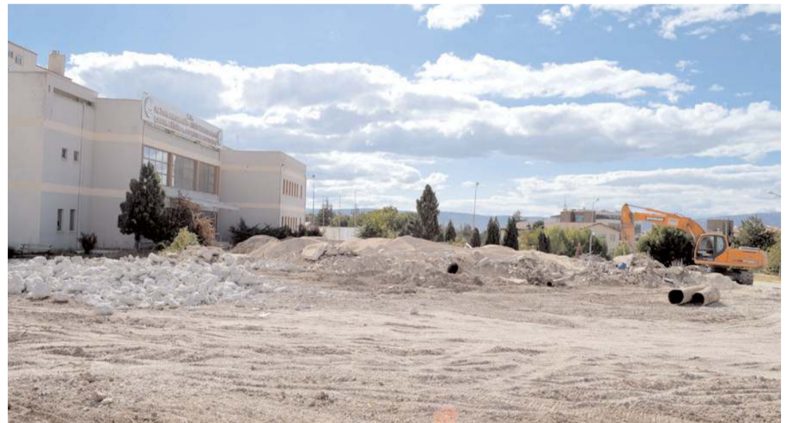
Devlet Hastanesinin eski binalarının yıkımı tamamlanmıştı.
