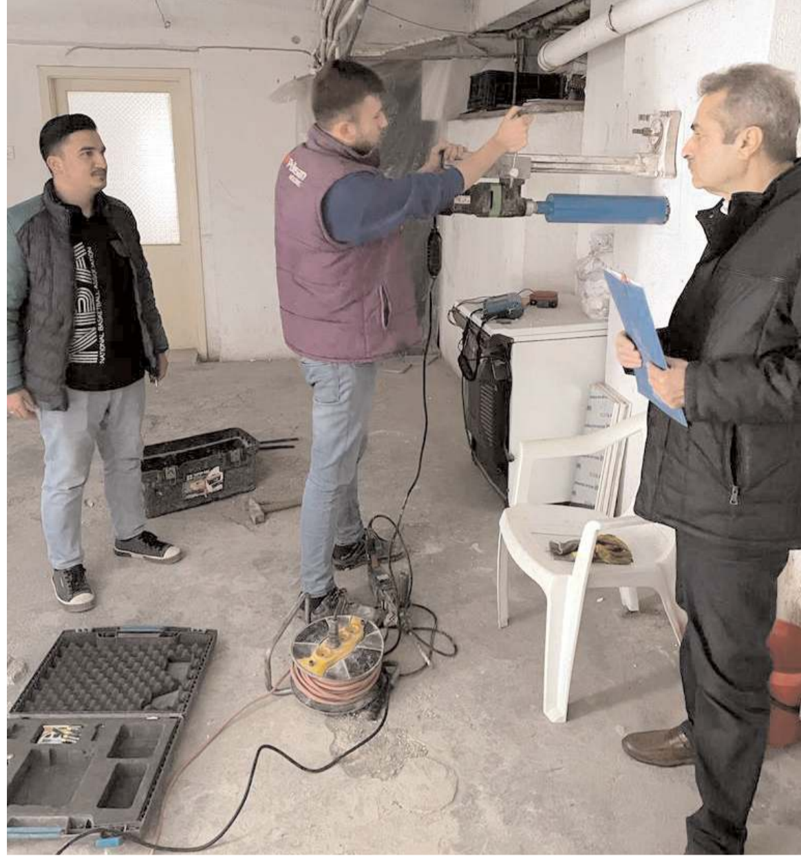
Test için binalardan karot alınıyor.
