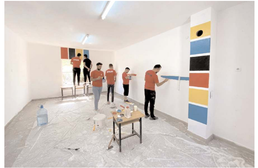
Gençler Kozören Köyü İlkokulu'nun bakım ve onarımını gerçekleştirdiler.
