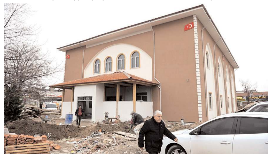
Mescidin dış cephesinde çalışmalar tamamlandı.
