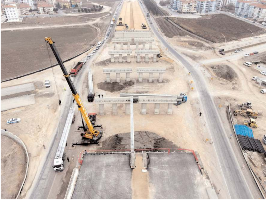
Farklı seviyeli köprülü kavşak projesi hızla devam ediyor.
