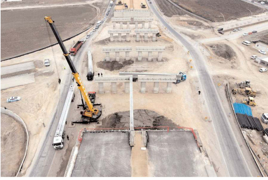
Farklı seviyeli köprülü kavşak projesi hızla devam ediyor.
