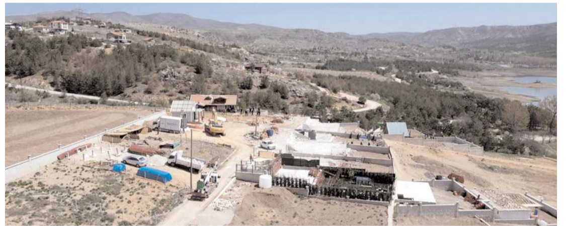
Çorum Belediyesi, yıkım çalışmalarını sürdürüyor.
