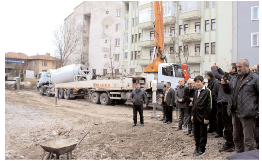
Hıdırlık Erkek Yatılı Hafız Kur'an Kursu yeni binası eski binanın olduğu yere yapılıyor.
