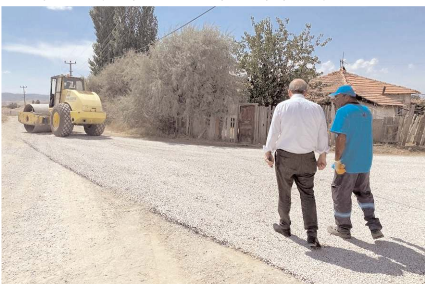
Gürpınar Mahallesi'nde sathi kaplama çalışması yapılırken...
