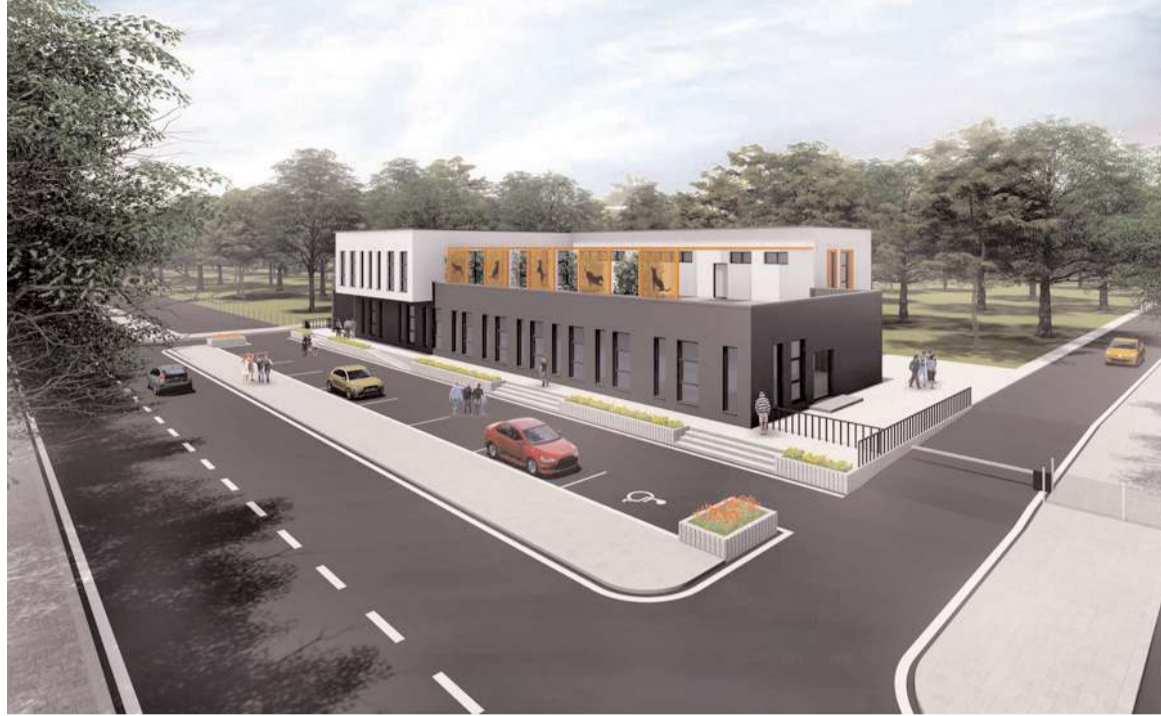
Çorum Belediyesi Hayvan Bakım Evi bittiğinde böyle olacak.
