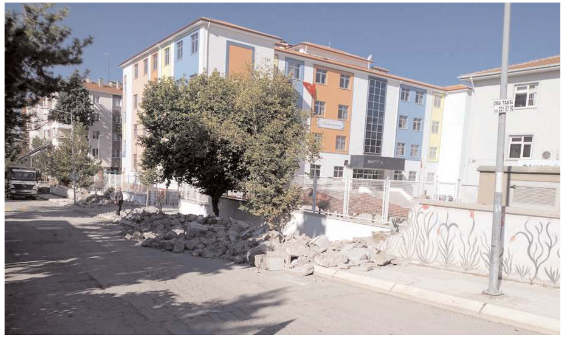
Belediye ekipleri eski duvarı yıkmak için çalışmalara başladı.
