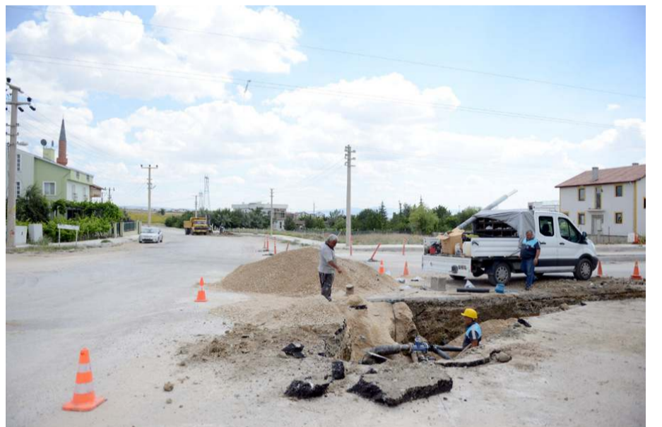
Ekonomik ömrünü doldurmuş boruları yeni sistem borularla değiştiriliyor.
