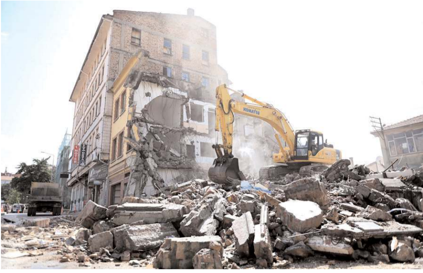
Yıkım çalışmalarından bir görüntü...
