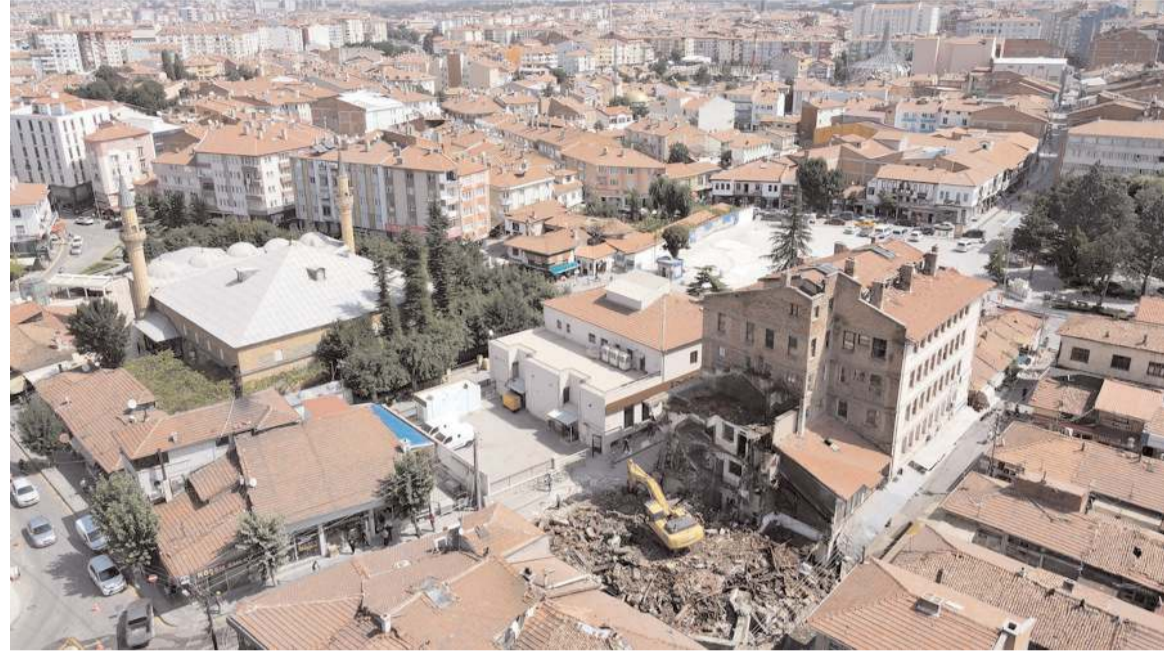
Çorum Belediyesi tarihi meydan için yıkım çalışmalarına devam ediyor.
