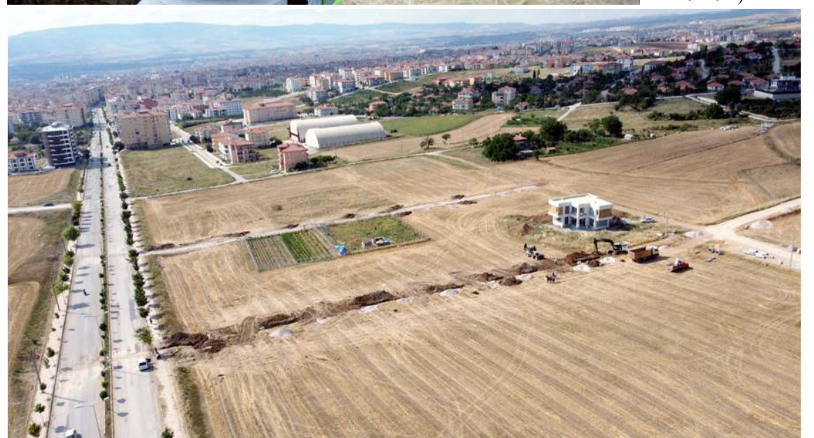
Bölgede 350 metre uzunluğunda kanalizasyon çalışması gerçekleştirilecek.
