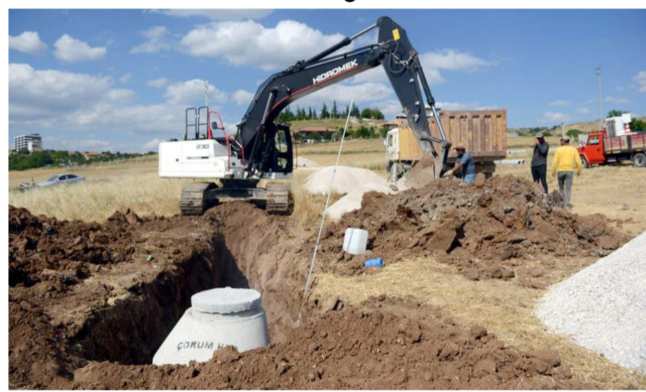
Bölgede 300 mm'lik betonarme borularla kanalizasyon hattı çalışması yapılıyor.
