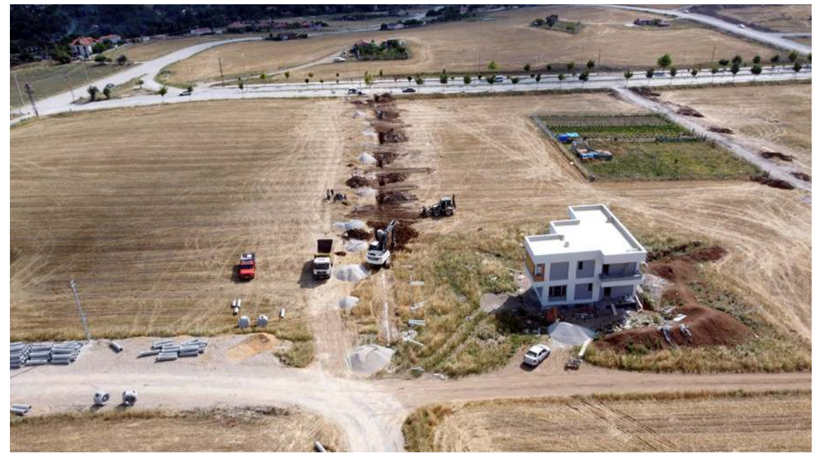
Çorum Belediyesi Bahçelievler Mahallesi Çoraklık 36. Sokak'ta kanalizasyon hattı çalışması başladı.
