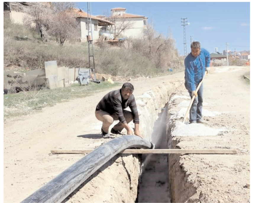
Asbest borular yeni borularla değiştiriliyor.
