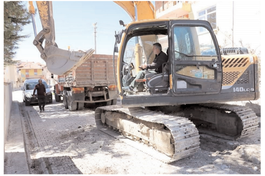
Asbest borular yeni borularla değiştiriliyor.
