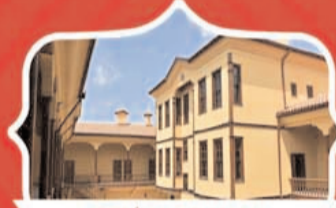
VELÎ PAŞA HANI RESTORASYONU
