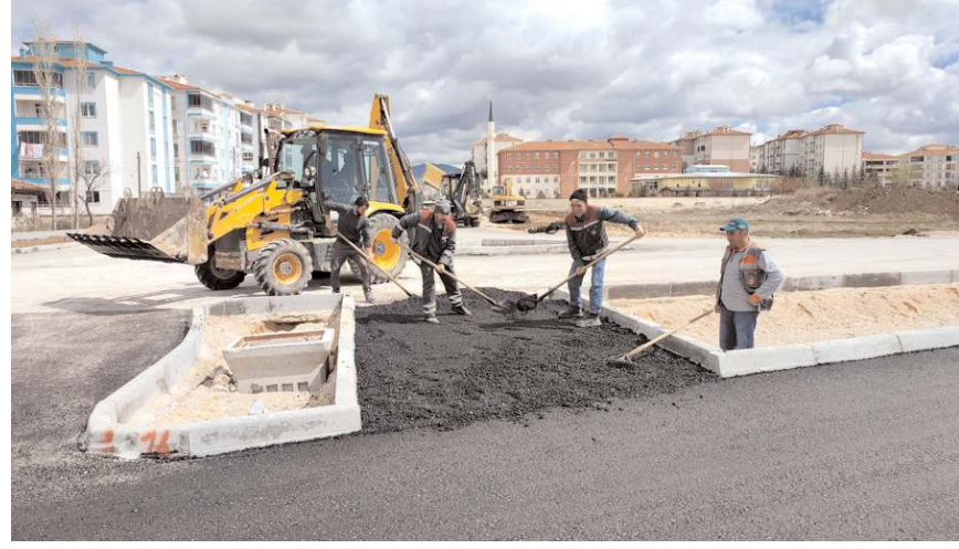
Çorum Belediyesi tarafından yapılan ve Çiftlik Pınarı Caddesi'ni Akşemseddin Caddesiyle buluşturacak olan 30 metre genişliğindeki yeni bağlantı yolunda çalışmalar son aşamaya geldi.
