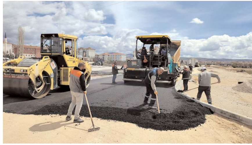
Yolda asfaltlama çalışmaları yapılıyor.
