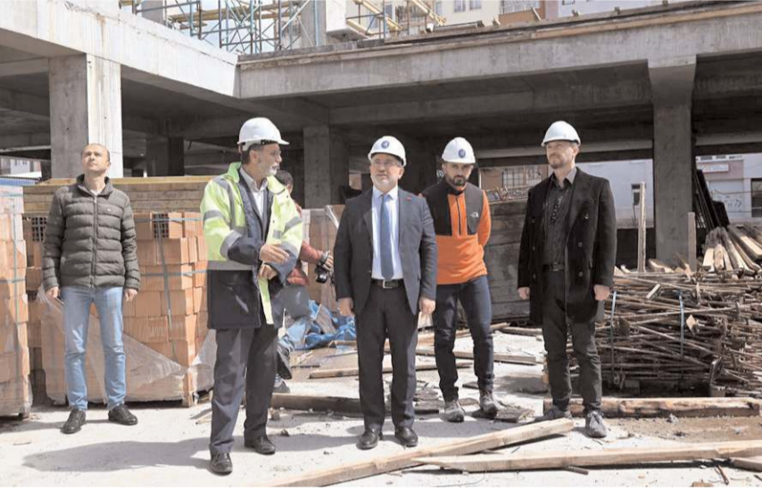
Başkan Aşgın, çalışmaların son durumu hakkında bilgi aldı.
