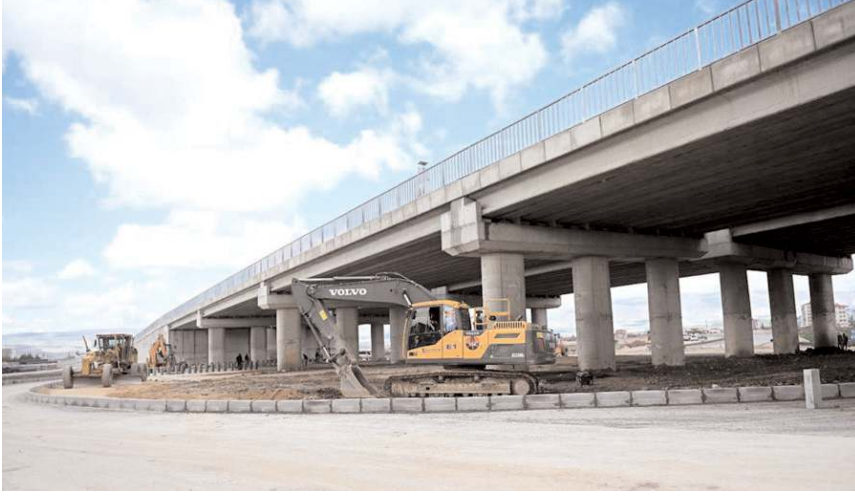
Kavşak projesinin kısa sürede tamamlanması için çalışmalar devam ediyor.
