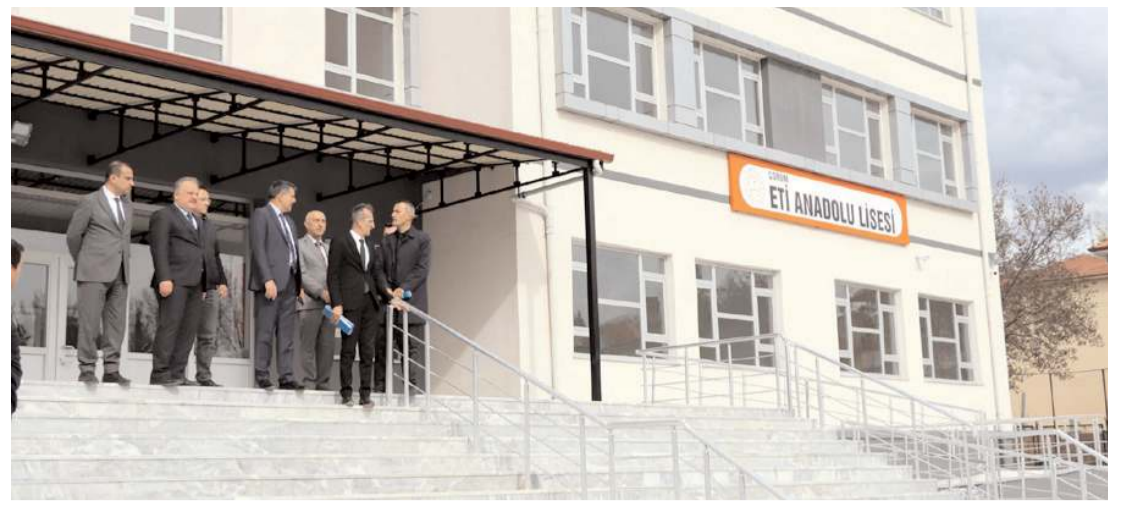
Eti Anadolu Lisesi yeni binasında inşaat çalışmalarının yüzde 98'i tamamlandı.
