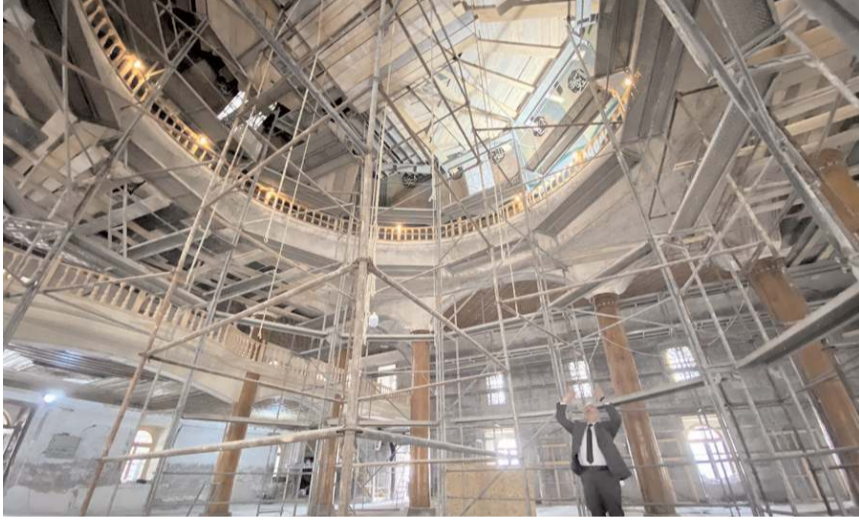
Ulu Camii'de restorasyon çalışmaları yoğun şekilde devam ediyor.
