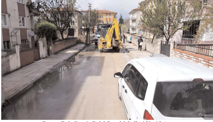
Çorum Belediyesi, Gülabibey Mahallesi Yenidoğan 5. Sokak'ta yağmursuyu hattı çalışmalarına başladı.
