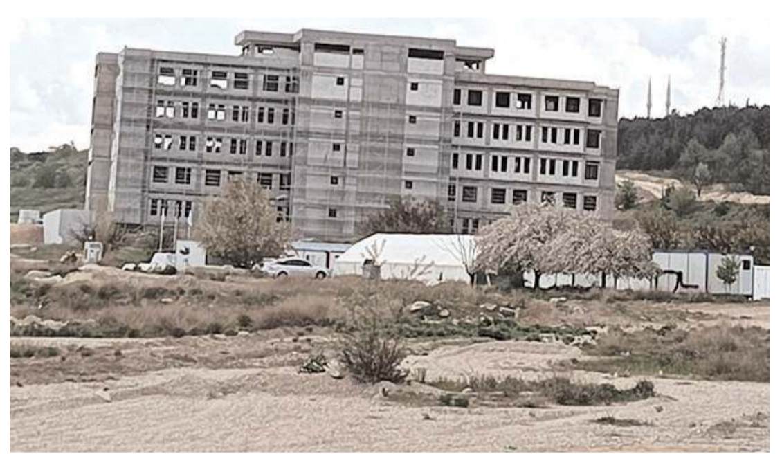
Diş Hastanesinin kaba inşaatı tamamlandı.
