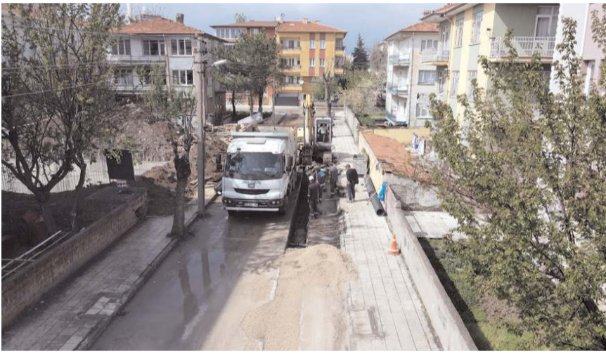
Kanalizasyon Müdürlüğü ekiplerince bölgede başlatılan çalışma kapsamında 300 mm'lik boru döşeniyor.
