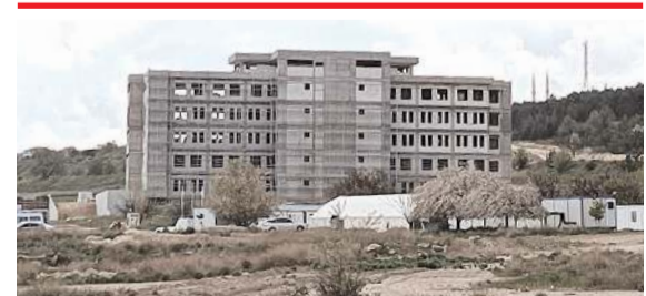
Diş Hastanesinin kaba inşaatı tamamlandı.
