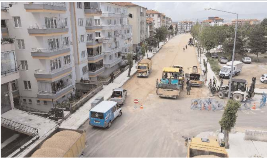
Alt yapısı tamamlanan caddenin asfaltı serilecek.
