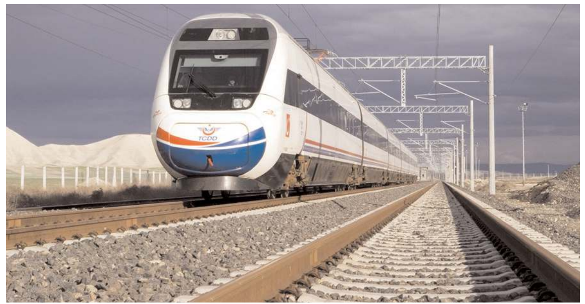
Demiryolu yatırımları kapsamında Delice-Çorum hızlı tren hattının 2028'e tamamlanacağı belirtildi.
